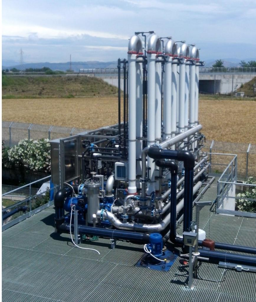
Figure 4: Reattore Trattamento Acque Reflue
