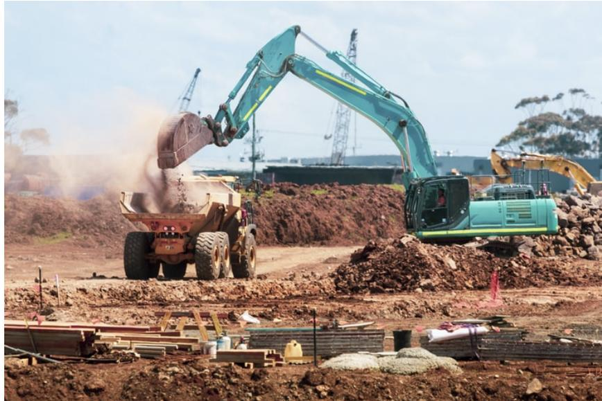
Figure 1: Fase di escavazione del terreno per un processo ex situ
